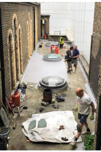
Au programme : changement des ardoises endommagées ; sécurisation des ardoises ayant bougé ; installation d'un filet de protection sous les vitraux plats latéraux ainsi qu' autour des parties exposées du toit pour empêcher toute chute d'ardoises dans la rue ; nettoyage des gouttières ; inspection et remise en marche de la cloche (demandez à Stéphane de la faire marcher !) et changement des dômes de protection des vitraux horizontaux des bas-côtés afin d'assurer leur étanchéité.
